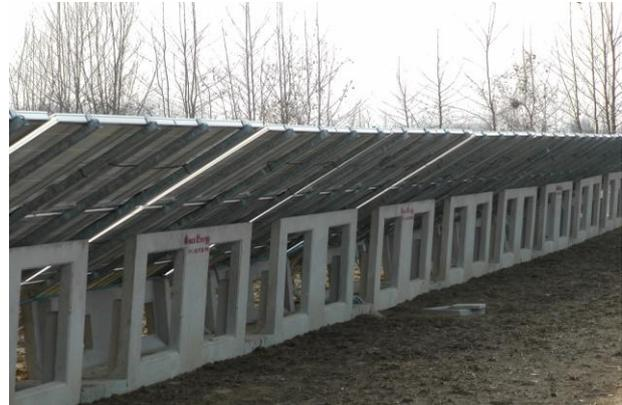
Il supporto, grazie al peso di 996 Kg è dotato di grande stabilità, inamovibilità sotto l'effetto delle intemperie e solidità strutturale documentata. Il particolare disegno permette un facile impilamento a terra e su camion che produce un notevole risparmio dei costi di trasporto, di stoccaggio e della movimentazione in cantiere.
